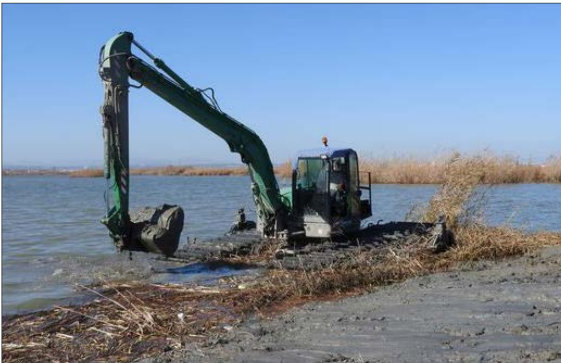
Figura 14. Restauración del perfil de las motas del lago de la Albufera (Valencia) durante 2020.
