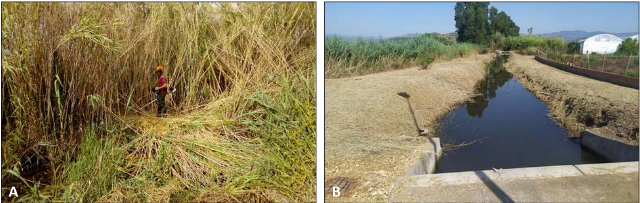
Figura 20. Acequia del Braç, (A) antes y (B) después del desbroce para la colocación de coberturas opacas. Marjal de Almenara, 2019.
