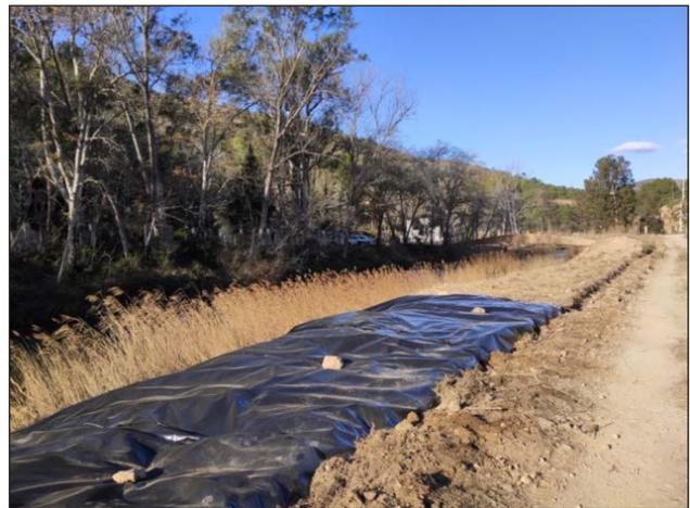
**Figura 10.** Izquierda. Instalación de cobertura opaca de polietileno de 2000 galgas para el control de cañaverales en el río Turia (Chulilla) en el marco de una actuación FEDER de restauración de hábitats. Derecha. Nótese la realización de una zanja en la parte superior para garantizar la fijación adicional de la cobertura y evitar su desplazamiento por el viento.
