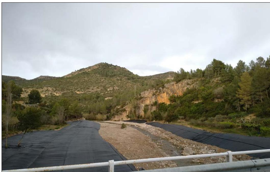
**Figura 7.** Cobertura para el control de cañaverales instalada en el río Villahermosa en el marco de las actuaciones de eliminación de *Arundo donax* en zonas de alto riesgo de incendio.
