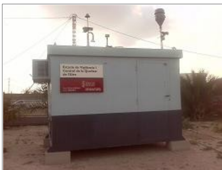
Foto: Estación de ELX-PARC DE BOMBERS
