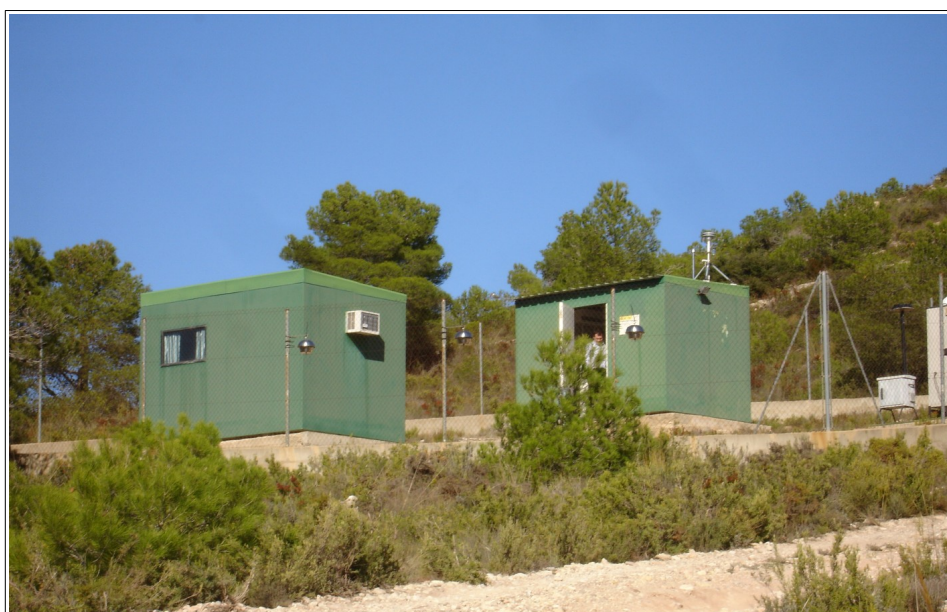
Foto: Estació de ZARRA
