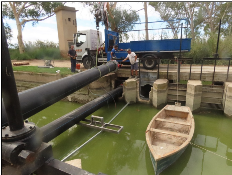
Imagen de la instalación de los tubos de recirculación
