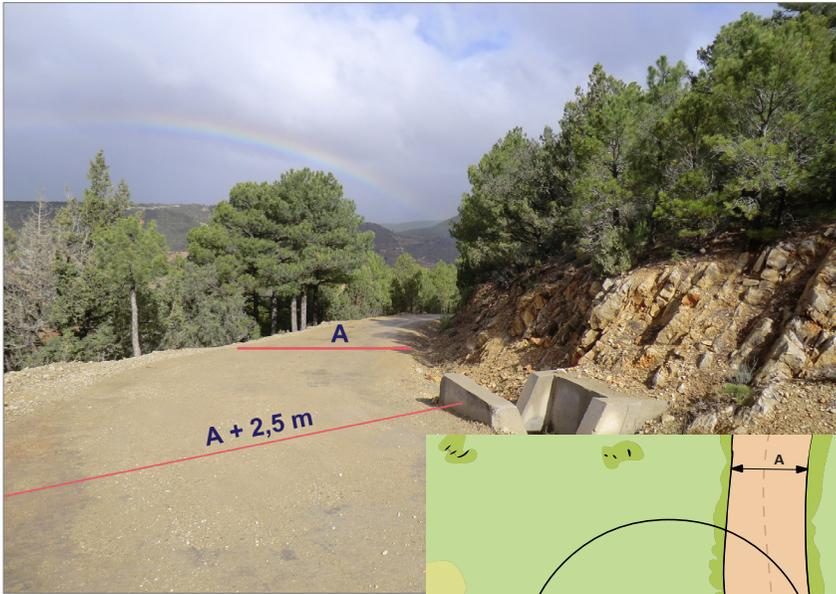
El carril de rodadura quedará dentro de una corona circular de radio máximo de 12,5 m y mínimo de 5,3 m. A: anchura del vial.
