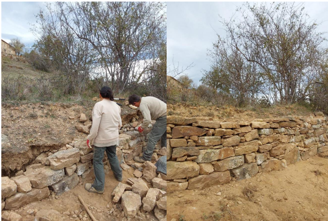
Imatge 2. Restauració de murs de pedra al LIC Penyagolosa (Xodos).
