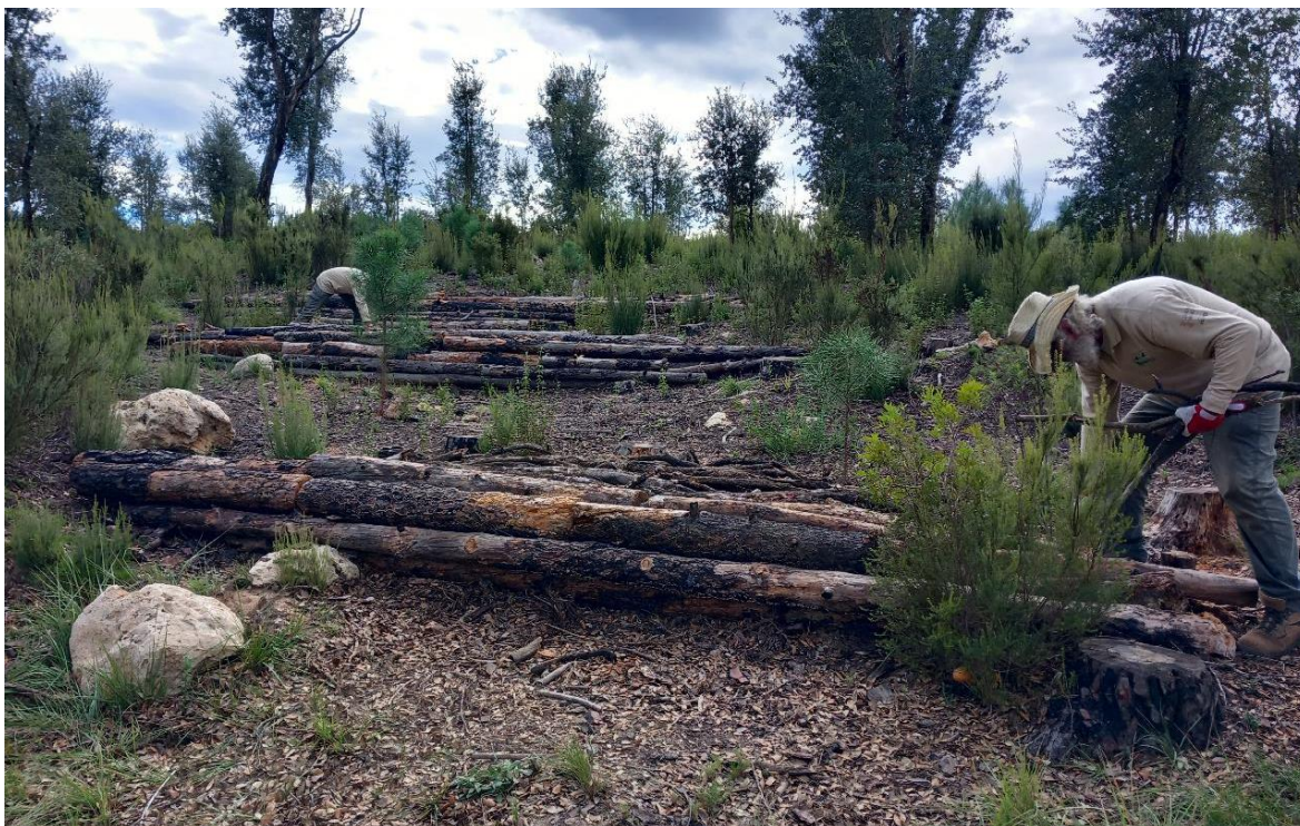
Imatge 4. Control erosió a la MRF Pla de Junquera - LIC Serres del Montdúver i Marxuquera (Pinet).
