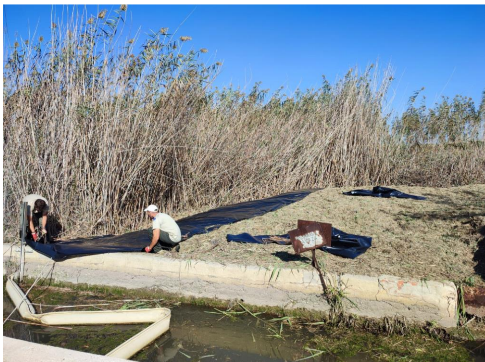
Imatge 1. Instal·lació cobertures opaques per al control d'espècies exòtiques invasores a la Marjal dels Moros (Sagunt).
