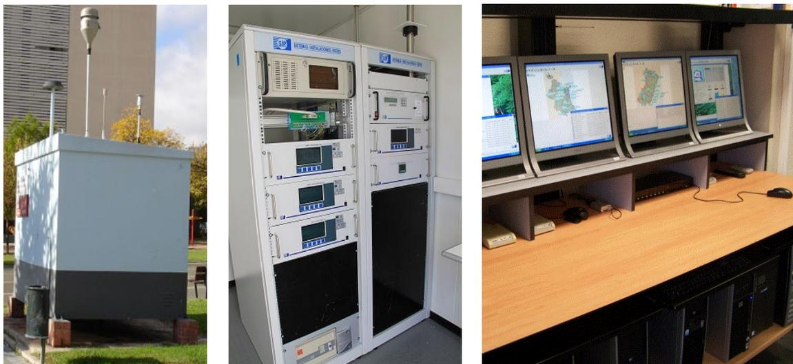
**Figura 3.** (Izquierda) Aspecto exterior de una estación de calidad del aire. (Centro) Monitores de gases en el interior de la cabina. (Derecha) Servidores y pantallas de seguimiento en el centro de control.
