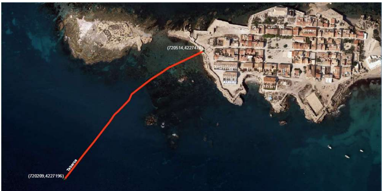
Figura 1. Localización del emisario y punto de vertido del emisario en aguas de la Isla de Tabarca.
